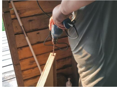
Proses pelubangan papan tangguh untuk jalur kabel
